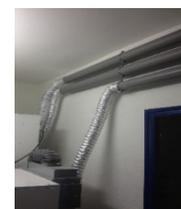
Evacuation basse température, dans un simple conduit PVC diamètre 100 mm, et une extraction vers l'extérieur en façade sans contrainte
